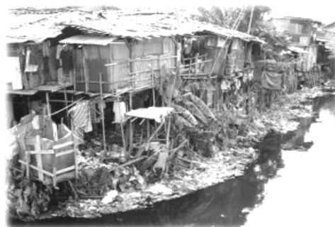
Gambar/Foto. Perumahan kumuh di pinggir sungai.
